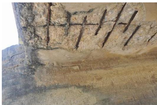
左の橋梁の頂版を下面から撮影。コンクリートが剥離し、鉄筋が露出している。
