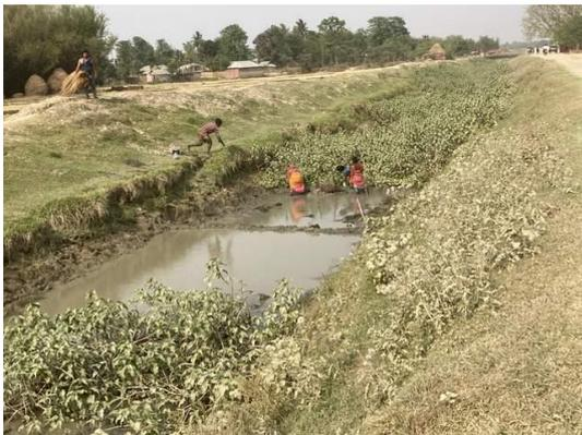
幹線用水路(中間付近): 地下水が幹線用水路表面に現れている。植生の繁茂が著しい。
