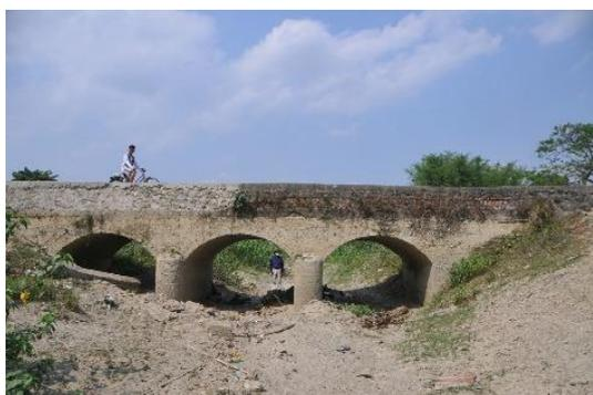
灌漑施設の当初整備された橋梁は、レンガ造りである。老朽化に伴いクラック(亀裂)が発生し、多くの橋梁は改修が必要である。
