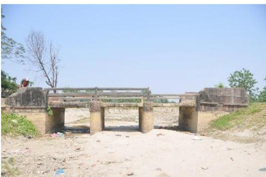
コンクリートで整備された橋梁であるが、特に頂版の劣化が著しく(写真右)、コンクリートが剥離して、露出した鉄筋が錆びている。
