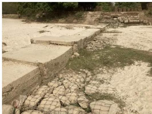
用水路サイホン(CUP7) : 幹線用水路下流側に設置されたサイホンである。カルバート部が露出しており、河川の洗堀が起きている。
