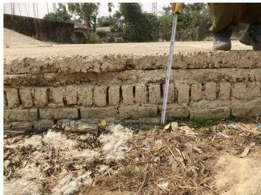
用水路サイホン(CUP2): 左写真と同じ構造物の、河川横断部天端の接写である。レンガが露出しており、サイホン内の水が漏水する。(現地聞取りから)
