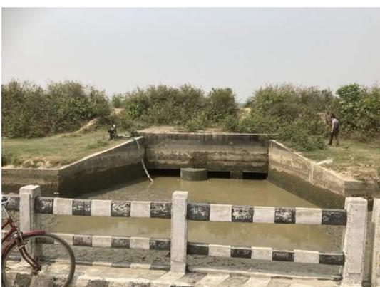
横断排水工(CDW-02) : アウトレット側から望む。幹線用水路からの漏水が、写真のように現れる。また、排水路整備が十分でないことから、常時湛水している。
