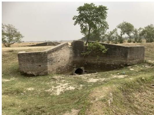
横断排水工 (CDW-11) : インレット側から望む。WUAからの補修要望があるものの、ウイングクラック以外、深刻な状況は確認されなかった。しかし、洪水の通水能力が不足していることが、洪水解析から判明した。
