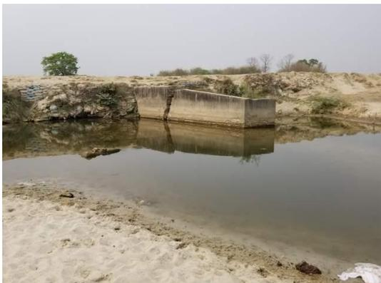
横断排水工 (CDW-07) : アウトレット側から望む。横断工全体の崩落を確認。幹線水路盛土も、土嚢により補強が施されているが、強度が十分とは言い難いと思料される。
