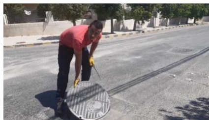
マンホール内の仕切り弁を操作して配水作業を実施している YWC 職員
