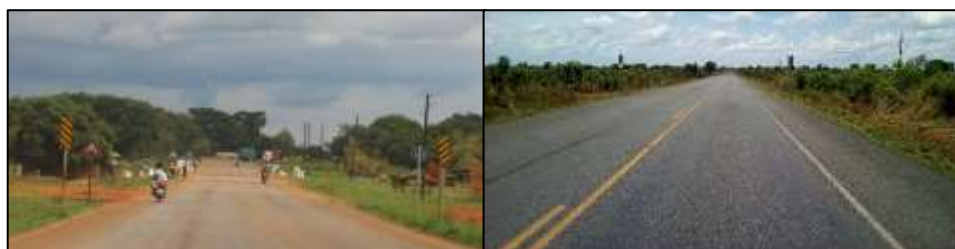
本事業により整備された道路区間（アティアク - ニムレ間）
