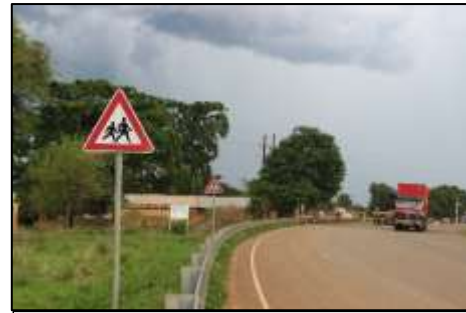
設置されたガードレール、道路標識
