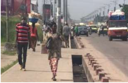
歩道・側構・縁石
