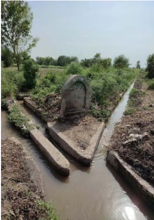
図 6 Lukhuana 三次水路からの灌漑用水が末端水路まで行き渡っている。
