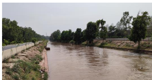
本事業で整備された三次水路
