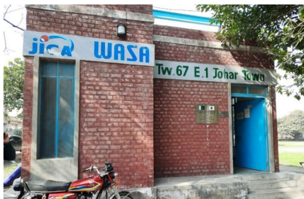
本事業が建設した深井戸施設
