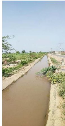
図 7 維持管理が行き届いている Padhyara 三次水路
