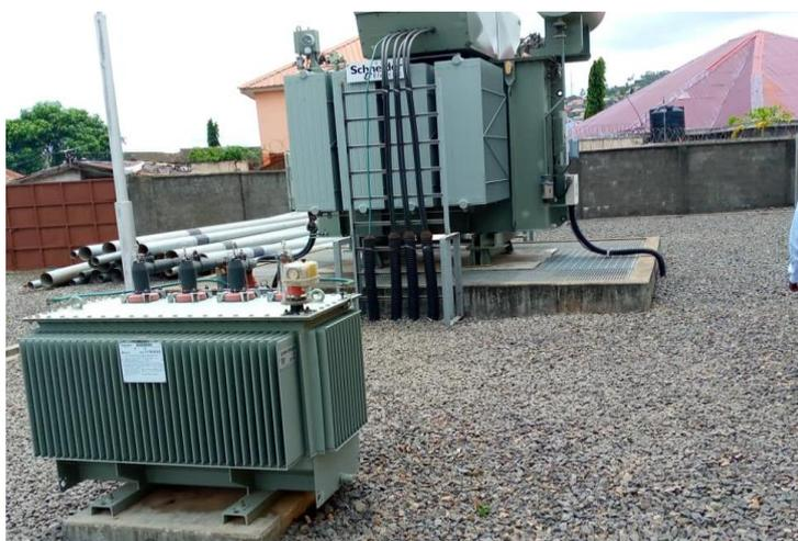
本事業で設置されたゴドリッチ一次変電所の変圧器
