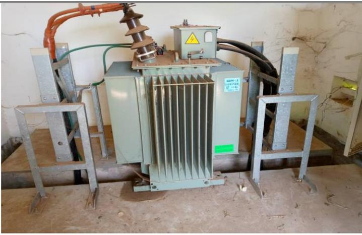
本事業で改修されたミルトン・マルガイ教育・技術大学二次変電所の配電変圧器
