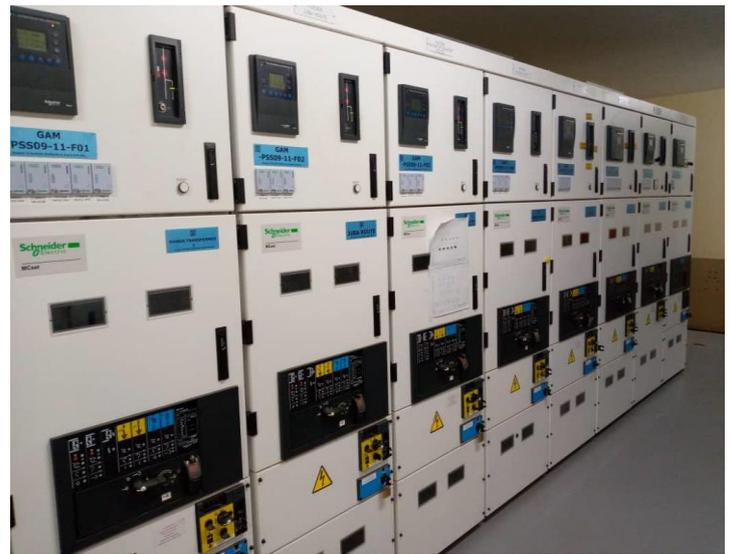
ゴドリッチ一次変電所の 11kV 配電盤
