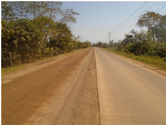
第3工区の未舗装区間
