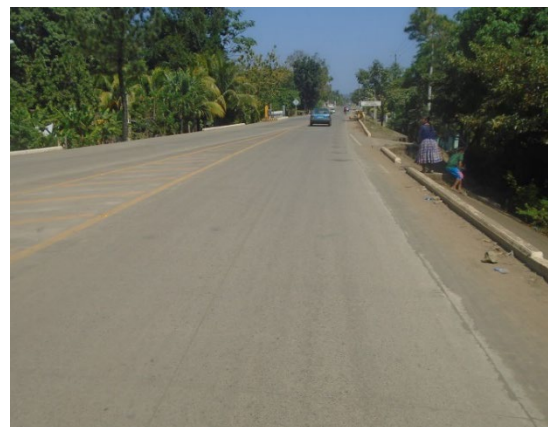
国道 7 号東線（第 4 工区）
