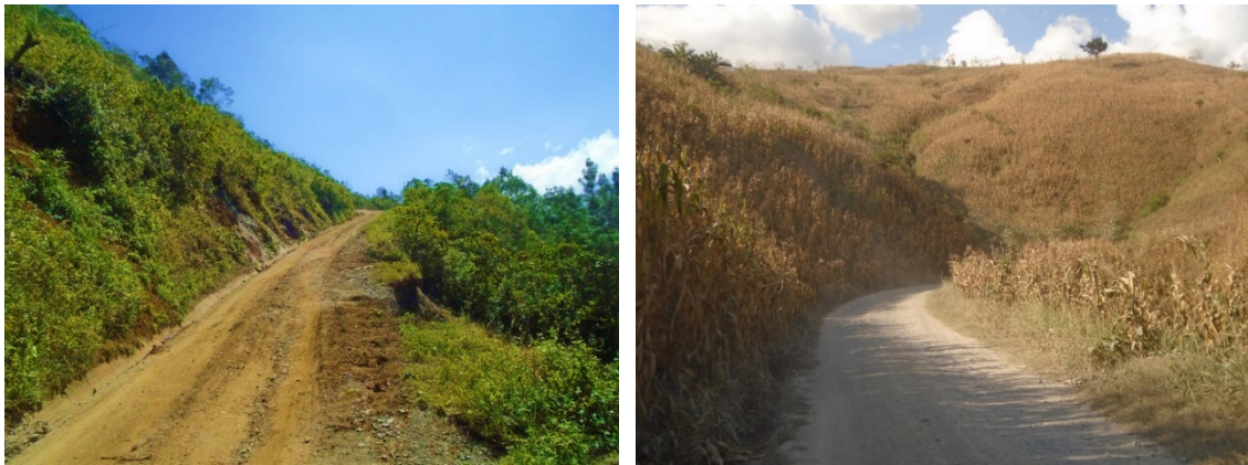
本事業により修復された農村道路
