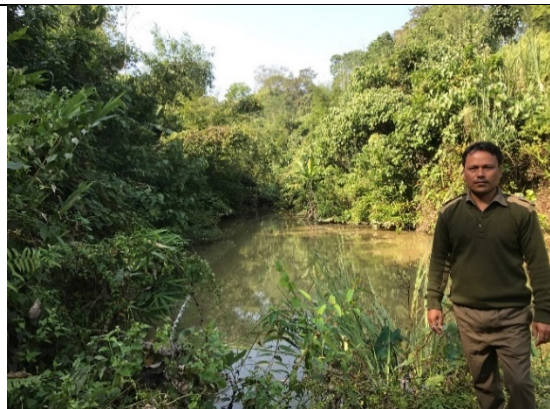
チェックダム (モデル 1) (Kumarghat Subdivision, Unakoti District)
