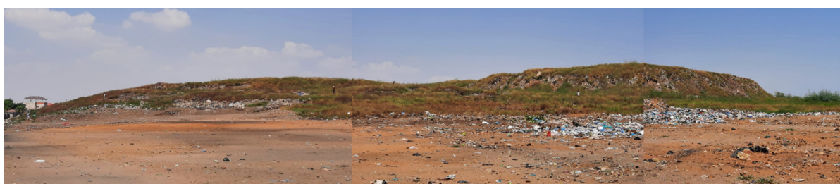
閉鎖済み最終処分場（Gulf 2 dumping site）
