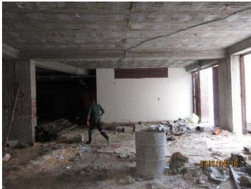
MRI 設置候補部屋内観 (工事中)
