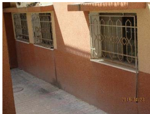
右側窓周辺壁を解体し、MRI を搬入
