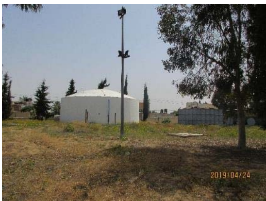
市水受水槽(白色)。井戸水受水槽
