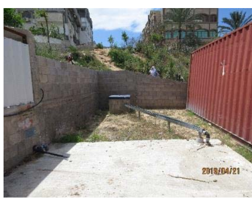
深さ 80m の井戸(奥)と受水槽(48 m 3 )
