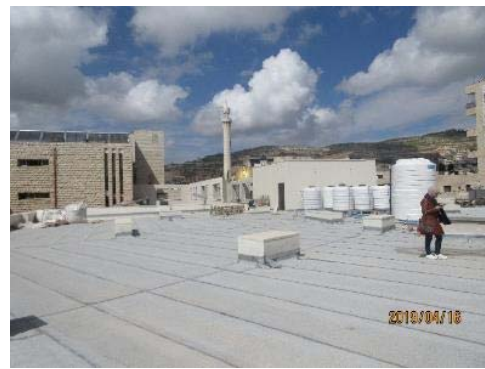
増床部分(現状はアスファルト防水屋根)
