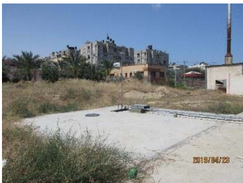
埋設型オイルタンク (60,000 リッター)
