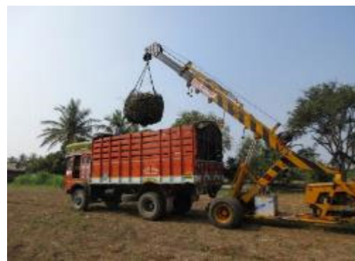
積替（クレーン車から運搬トレーラー）
