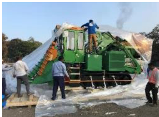
製糖工場における機材の開梱作業
