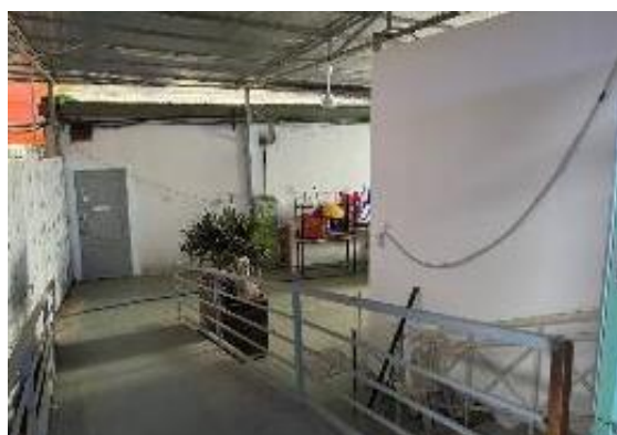
実証予定のスペース入口 (現在は倉庫だがリノベーションの予定)
