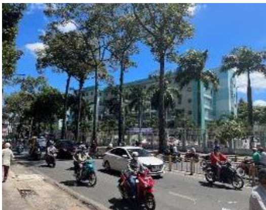
普及・実証・ビジネス化事業実施予定のグエンチーフン病院 西南からみた病院全景 (南側は片側幅員2車線の地方道)
