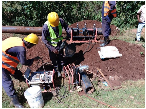
電気融着に用いる機器類
