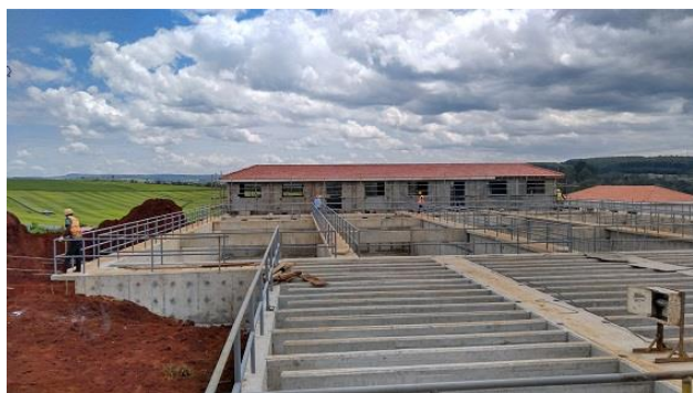
ケリチョウ町で建設が進む新規浄水場
