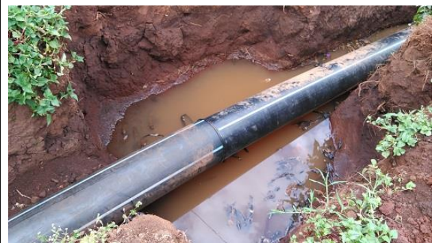
ケリチョウ町の新規配水管布設現場（KfW 融資）
