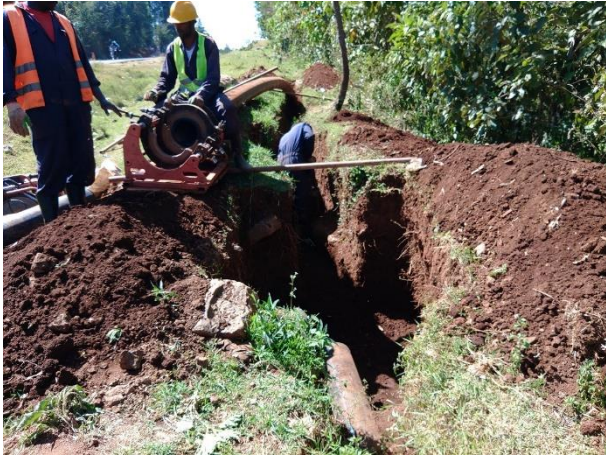
電気融着法による HDPE 管の接続
