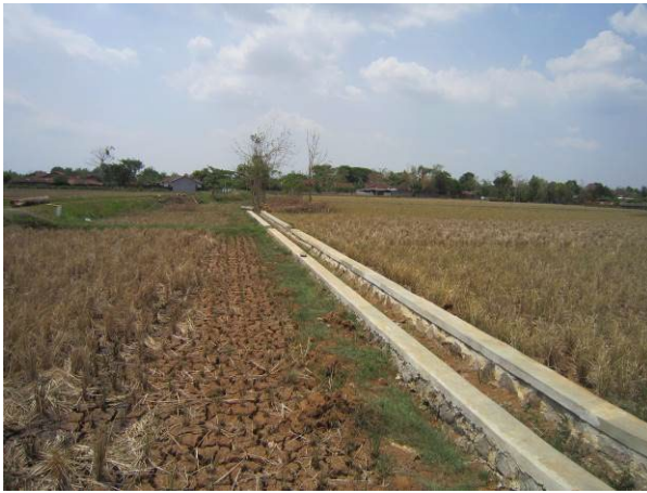
左側：三次水路（中部ジャワ州） 右側：土水路（西部ジャワ州）
