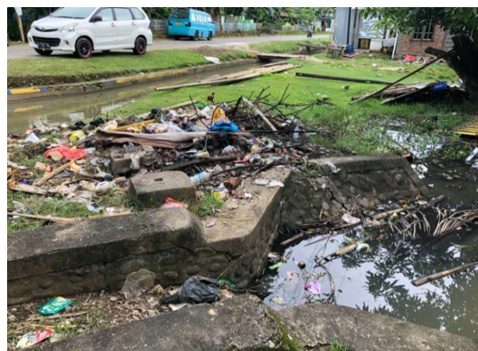
二次水路から三次水路への取水箇所 溜まった家庭ごみ
