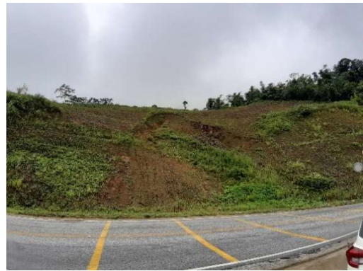
実証候補サイトの調査（国道 6 号線）
