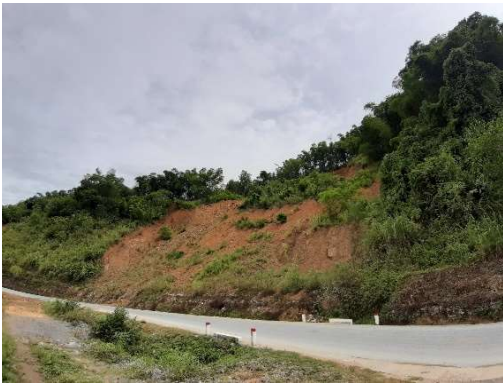
実証候補サイトの調査（国道 7 号線）
