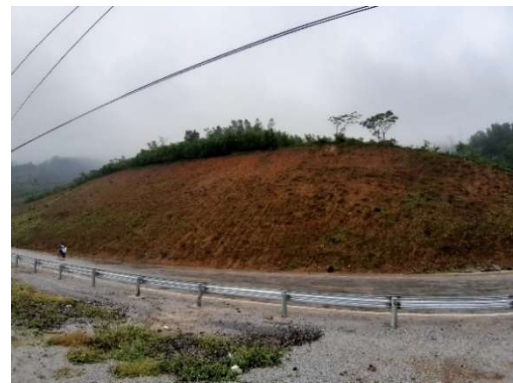
実証候補サイトの調査（国道 9 号線）
