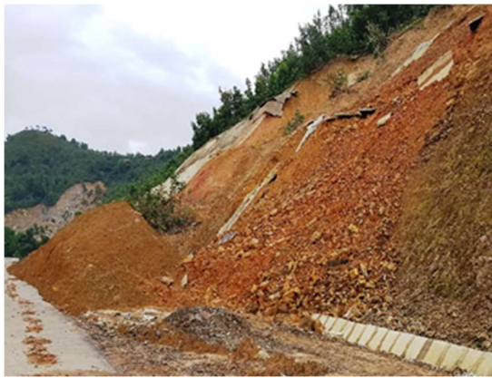
図1 高速道路でののり面表層崩壊（LA SON～TUY LOAN 線）
