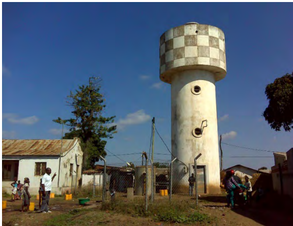
高架水槽 (V=30m 3 ) と深井戸施設
