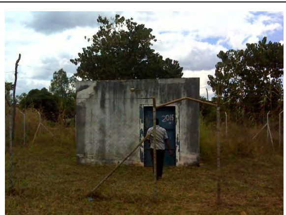
ポンプ室 (深井戸用)
