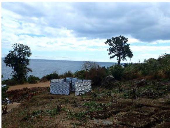
メタングラ市役所により建設中のニアッサ湖からの取水施設建設現場。2017/06/26 撮影
