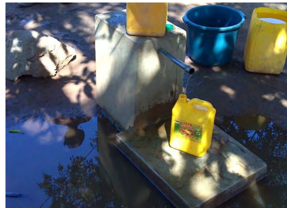
公共水栓 (水栓なし)
