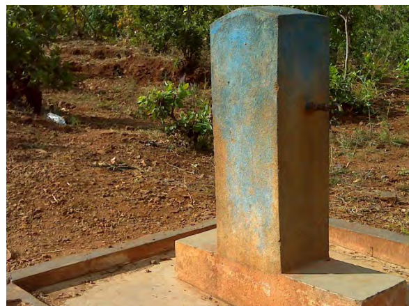
公共水栓（水栓なし）
