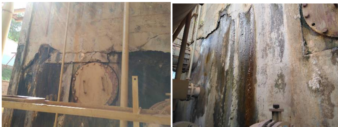
図 5.5-5 Nzove 1 浄水場の接触酸化処理施設の亀裂と水漏れ様子
