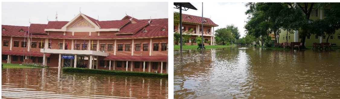
図 56：正門から自動車学科棟まで幅広く浸水
