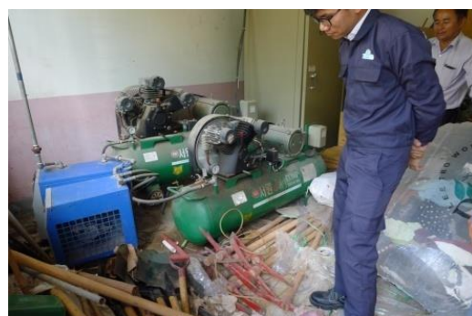
図 28：エアコンプレッサー修理
