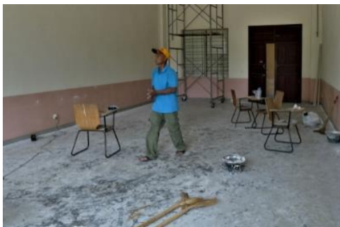
図 19：e ラーニング教室改装工事
