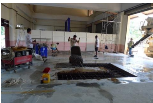
図 27：実習場床工事
