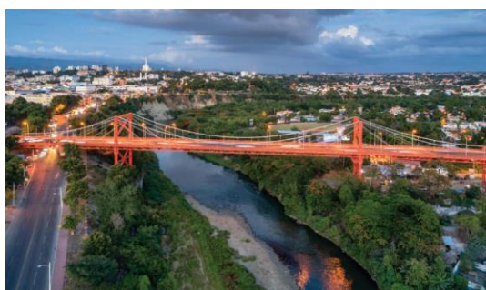
図 2.4.7 Bridges : Santiago and La Romana
