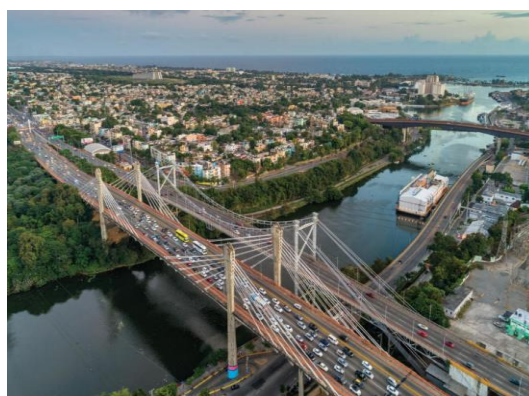
図 2.4.8 Bridges : Santo Domingo
