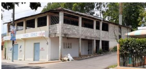
図 2.3.3 informal construction の増築事例
