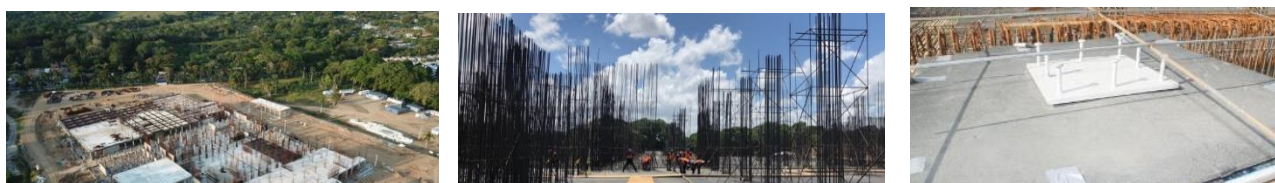
図 2.3.10 地域大学病院サン・ビセンテ・デ・ポール (HRUSP) の建設現場
