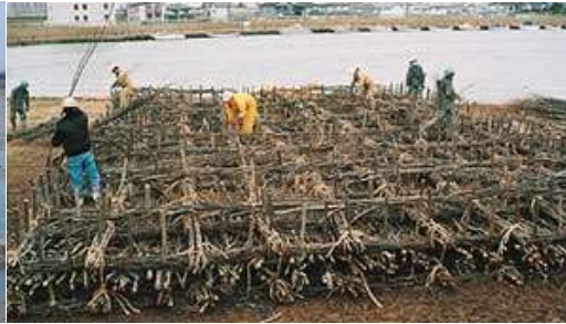
Fascine Mattress (erosion control)
