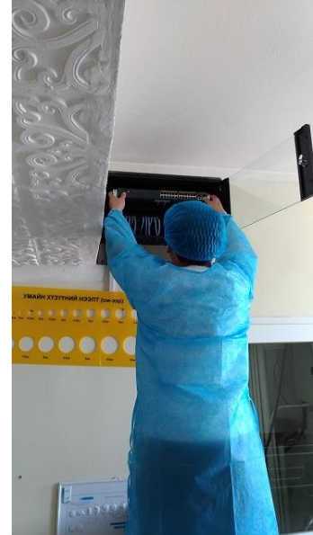
集中監視システム LAN 工事
