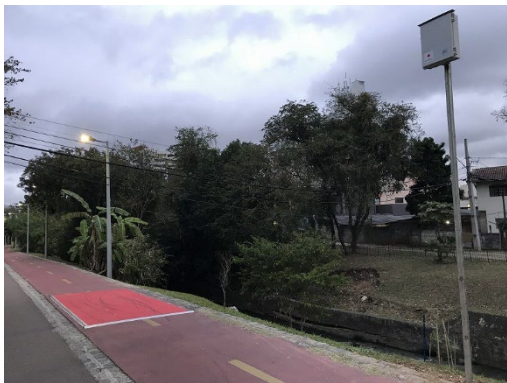
機材据付後（TYPE1、TYPE2）（2018年7月）
