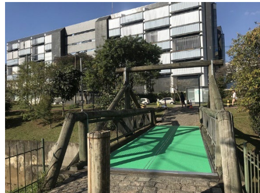
機材据付後（TYPE3:橋部）（2018年7月）
