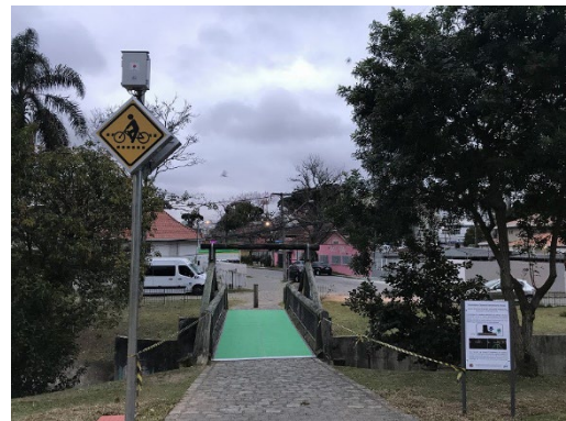
機材据付後（TYPE1 標識部/TYPE3）（2018年7月）
