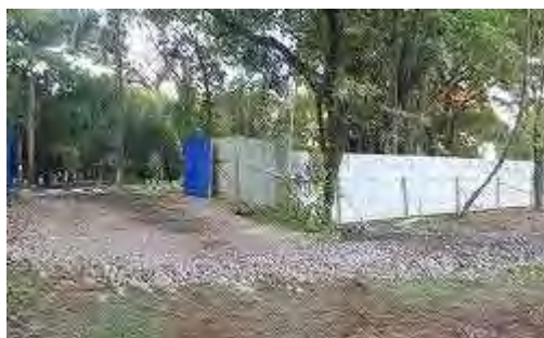
現場ゲート状況
