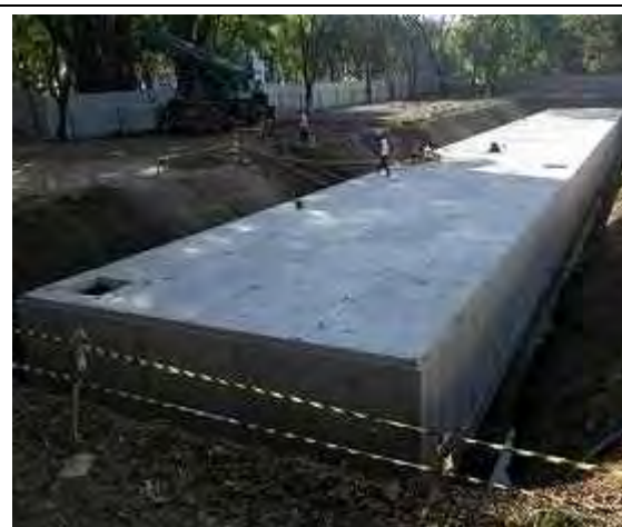
【第9回渡航 フレキャスト据付完了】
