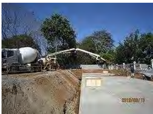
コンクリート打設状況
