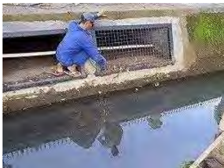
フィルター改修状況
