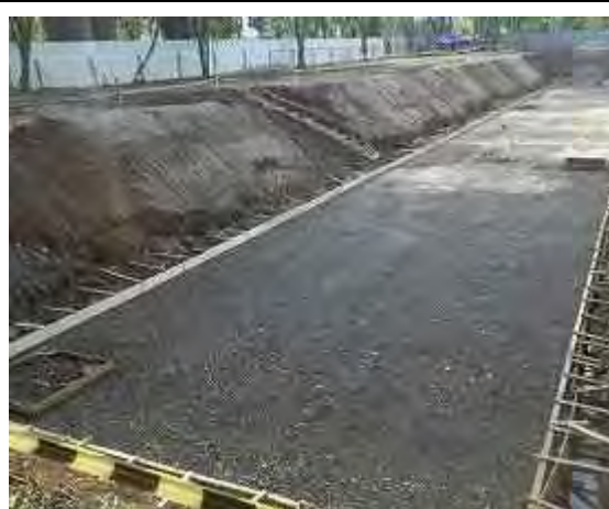
【第9回渡航 基礎碎石完了】
