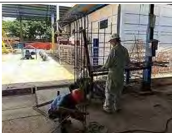
【第6回渡航 鉄筋組立加工状況】
