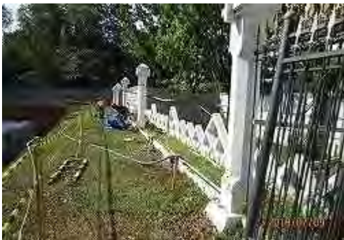
フェンス撤去状況
