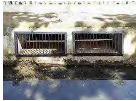
フィルター改修完了
