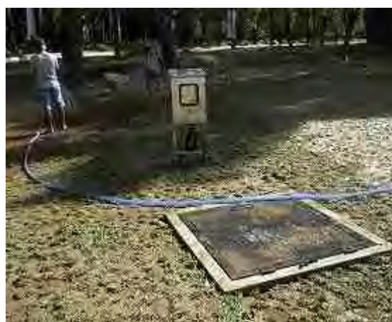
【第 12 回渡航 排水設備設置完了】
