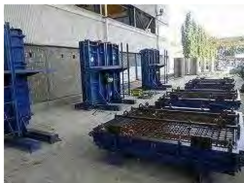
型組状況 頂版スラブ
