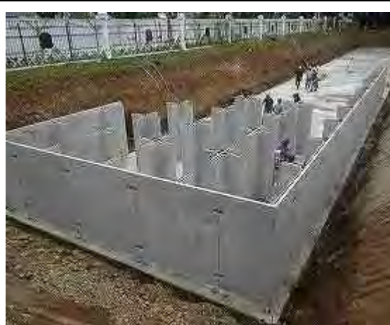
【第9回渡航 プレキャスト据付状況】
