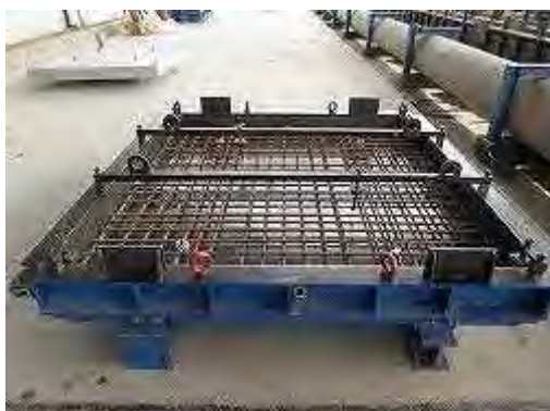
型組状況 頂版スラブ
