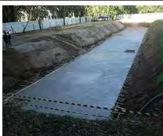
【第9回渡航 均しコンクリート打設完了】
