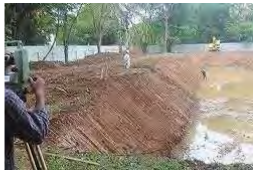
掘削出来高確認状況
