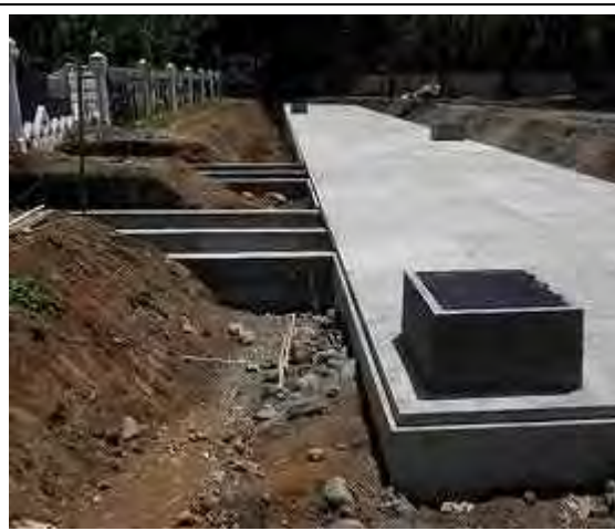
【第 12 回渡航 流入水路打設完了】
