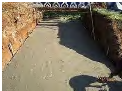
基礎コンクリート打設完了
