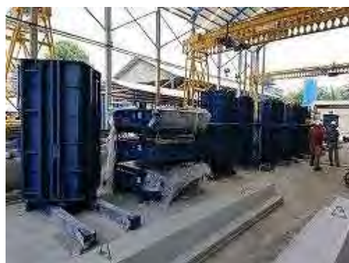
型枠搬入状況
