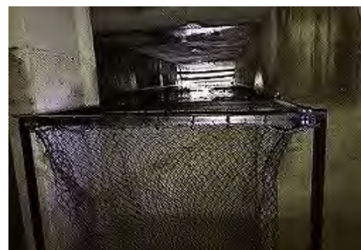
貯留槽内 回収ネット設置完了
