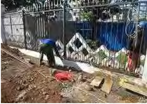
フェンス復旧状況
