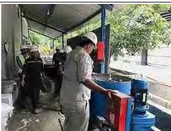
【第6回渡航 生コン試験練り】
