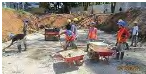
コンパクション状況
