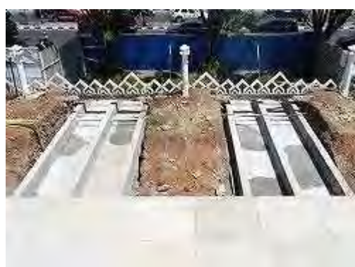
流入水路施工完了
