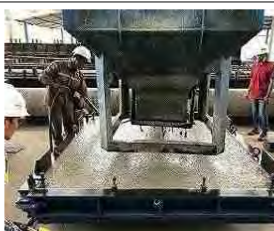
【第6回渡航 頂版スラブ打設状況】
