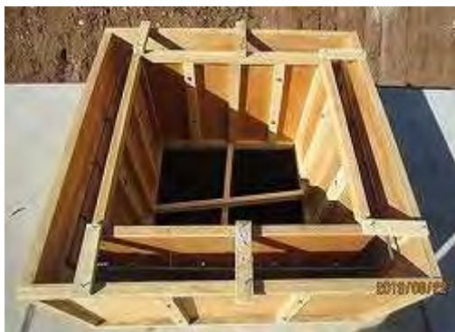
マンホール型組状況
