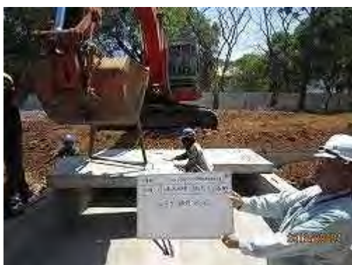
スラブ据付状況
