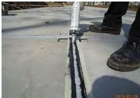
頂版スラブ 目地コーキング 状況
