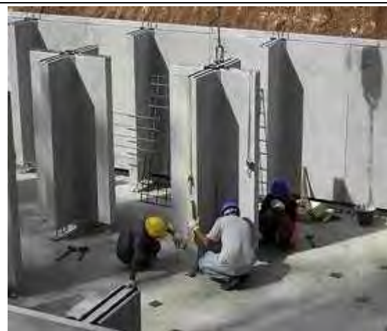
【第9回渡航 フレキャスト壁部据付状況】
