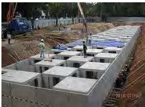
底版コンクリート打設状況
