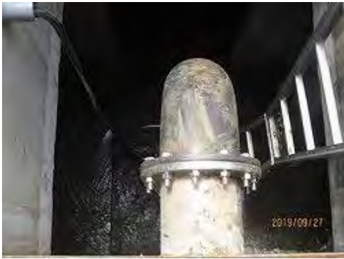
排水ポンプ設置状況
