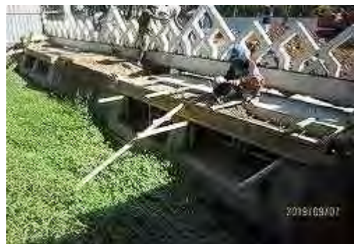
フェンス復旧状況
