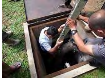
貯留槽内に降りる様子
