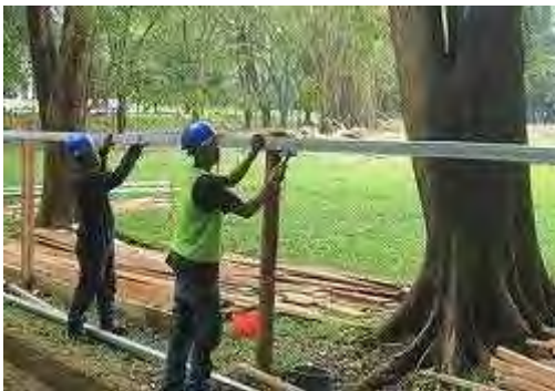
フレーム設置状況
