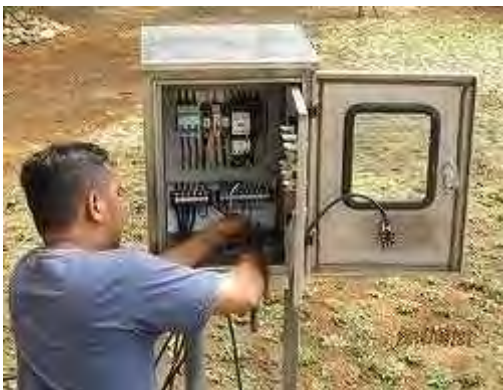
コントロールパネル設置
