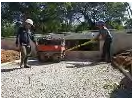
基礎砕石の転圧状況
