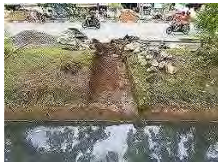
通水路改修状況
