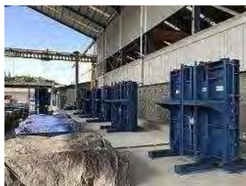
養生 頂版スラブ
