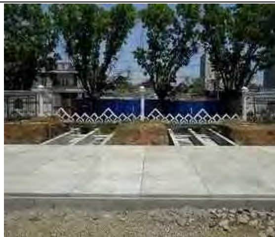
【第 12 回渡航 流入水路打設完了】
