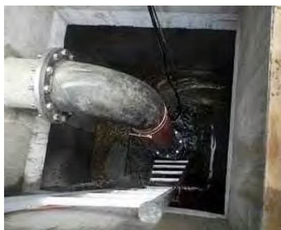
【第 12 回渡航 排水設備設置完了】
