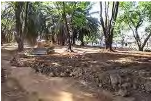
公園不陸改善状況
