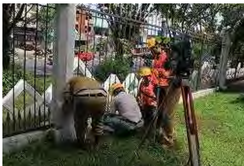
測量状況（トータルステーション）
