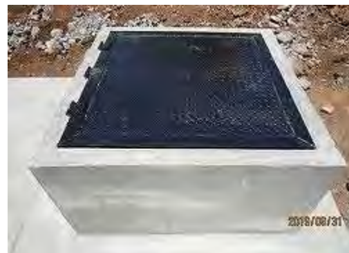
マンホール工完了
