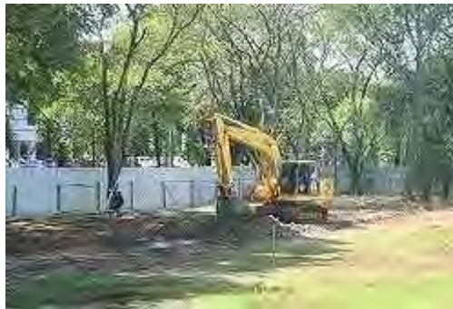
仮道路建設中
