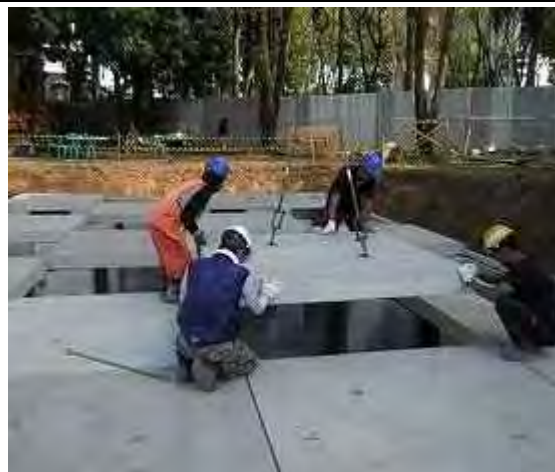
【第9回渡航 スラブ据付状況】
