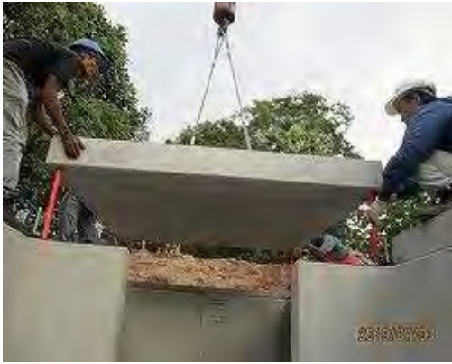
頂版スラブ 据付状況
