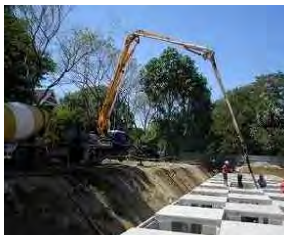
【第9回渡航 底版コンクリート打設状況】
