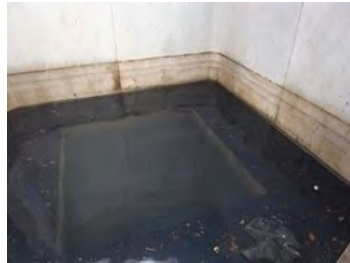
最上流点検口下の堆砂
