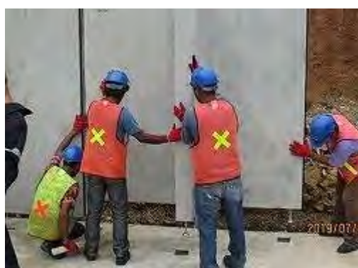
壁材（T型）据付状況
