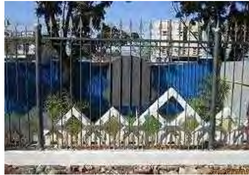
フェンス復旧完了
