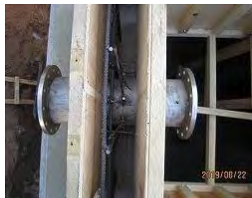
配管設置状況
