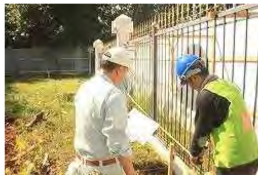
測量データ再確認状況
