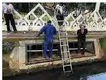
フィルター改修状況
