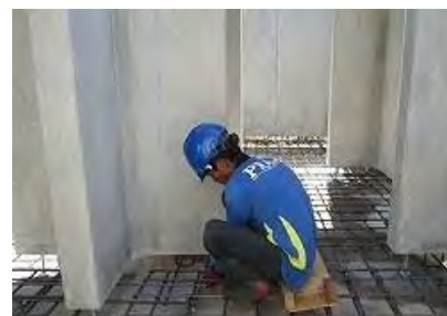
鉄筋組立状況
