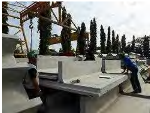
積込状況 壁材 T 型
