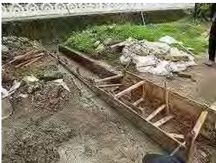
通水路改修状況
