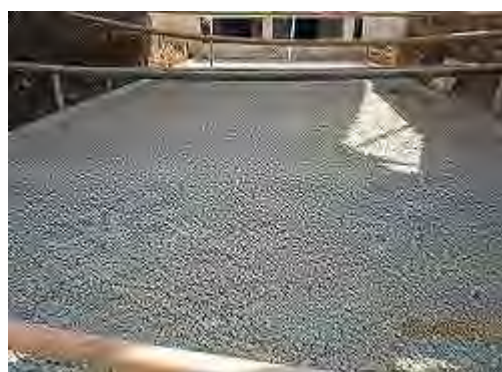
基礎砕石完了
