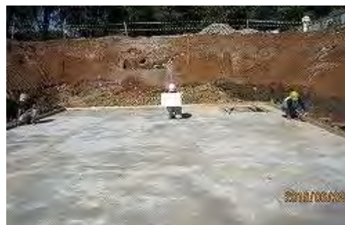
均しコンクリート完了
