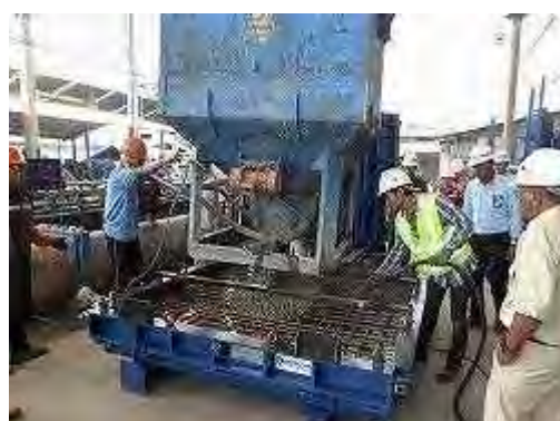
打設状況 頂版スラブ
