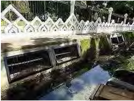
フィルター改修完了
