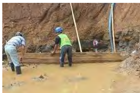
排水溝設置状況
