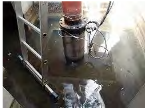
排水ポンプ設置状況
