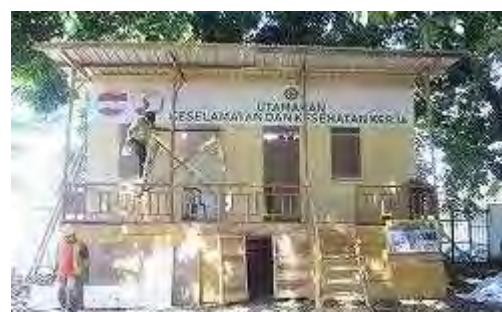
仮事務所建設状況
