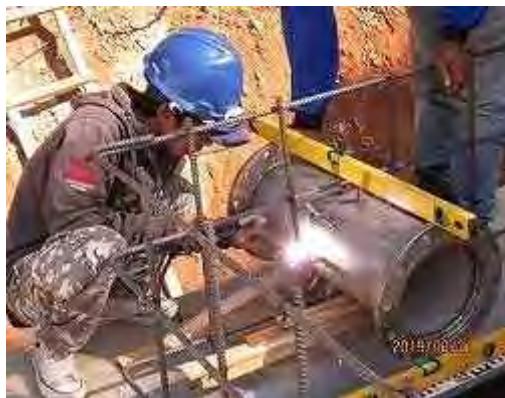
配管設置状況
