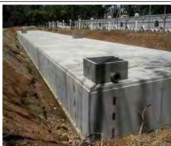
【第12回渡航 マンテンスホール打設完了】
