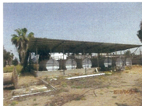
オイルタンク(20,000 リットル x 6 台)
