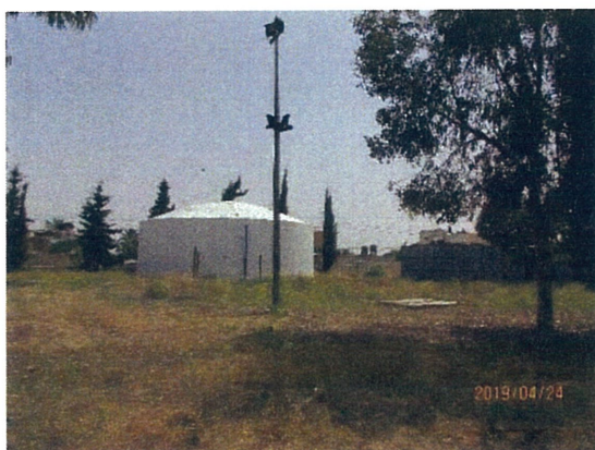
市水受水槽(白色)。井戸水受水槽
