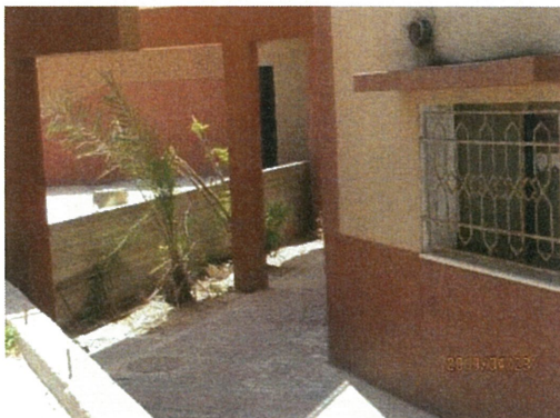
MRI 設置候補部屋外観（右部屋）
