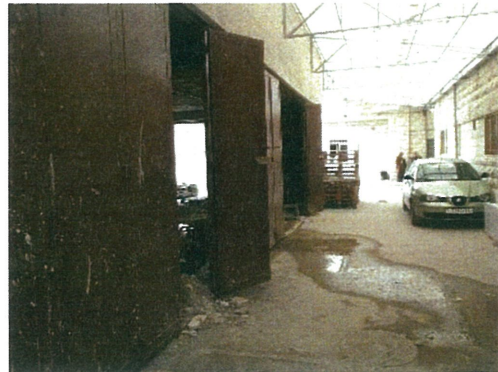
MRI 設置候補部屋外観（左部屋）
