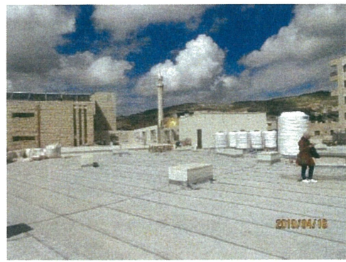
増床部分(現状はアスファルト防水屋根)
