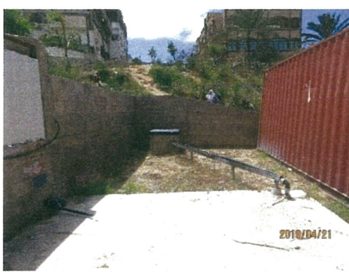
深さ 80m の井戸(奥)と受水槽(48 m 3 )
