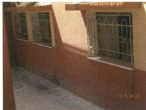
右側窓周辺壁を解体し、MRI を搬入
