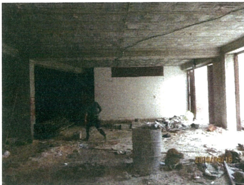
MRI 設置候補部屋内観（工事中）
