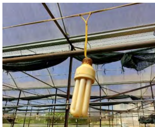
ダラット市内のキク農家で使用される蛍光灯電球。自前で配線工事をしている（ラムドン省ダラット市、2020年11月19日）
