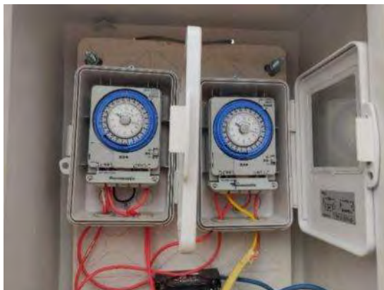
電照タイマー（22時～2時の4時間点灯）（ポテト研圃場、2021年4月6日）
