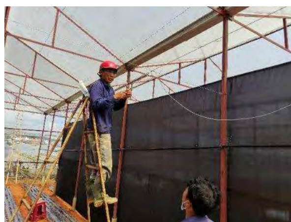
試験栽培の試験機材の設置作業 (ポテト研圃場、2021年2月5日)
