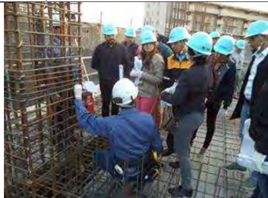
Capacitación en Japón : Inspección de calidad de la construcción (15 de noviembre del 2017)
