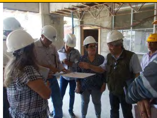
Explicación sobre las inspecciones de construcción en Salinas (23 de octubre del 2017)
