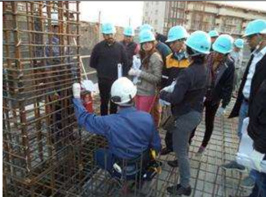
本邦研修：施工品質検査実習（2017年11月15日）
