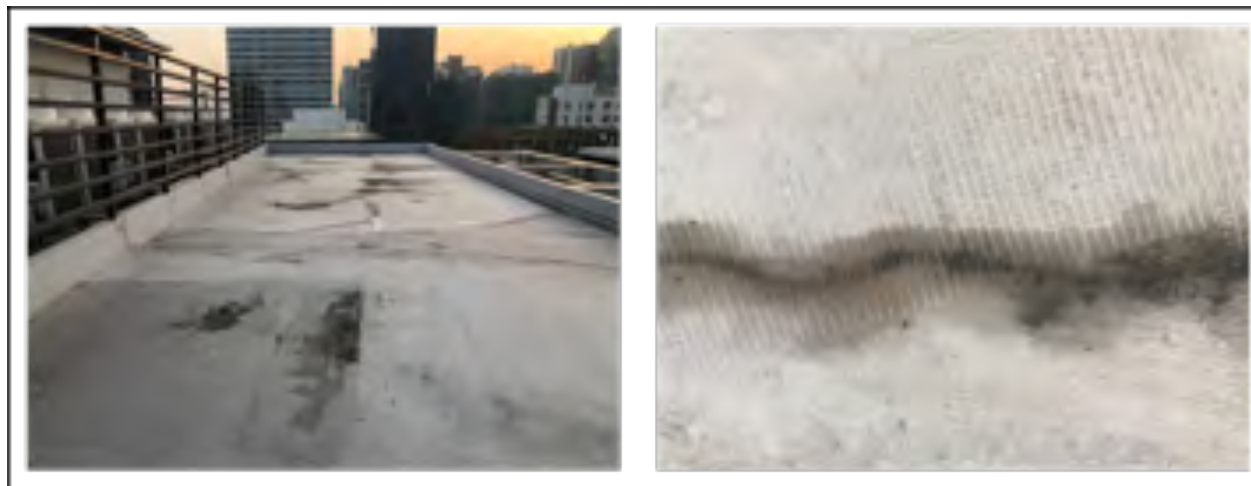
図 8 本社ビルの屋上
