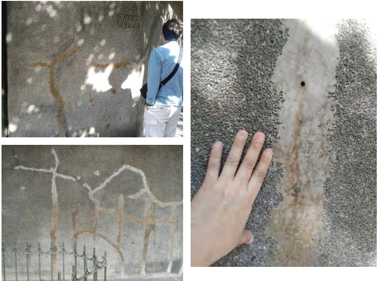
図 19 現地でのコンクリート補修状況
