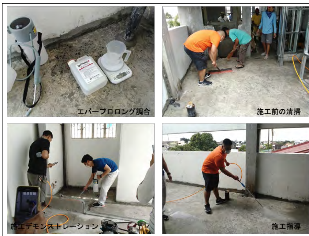
図 15 エバープロロング施工のデモンストレーション1
