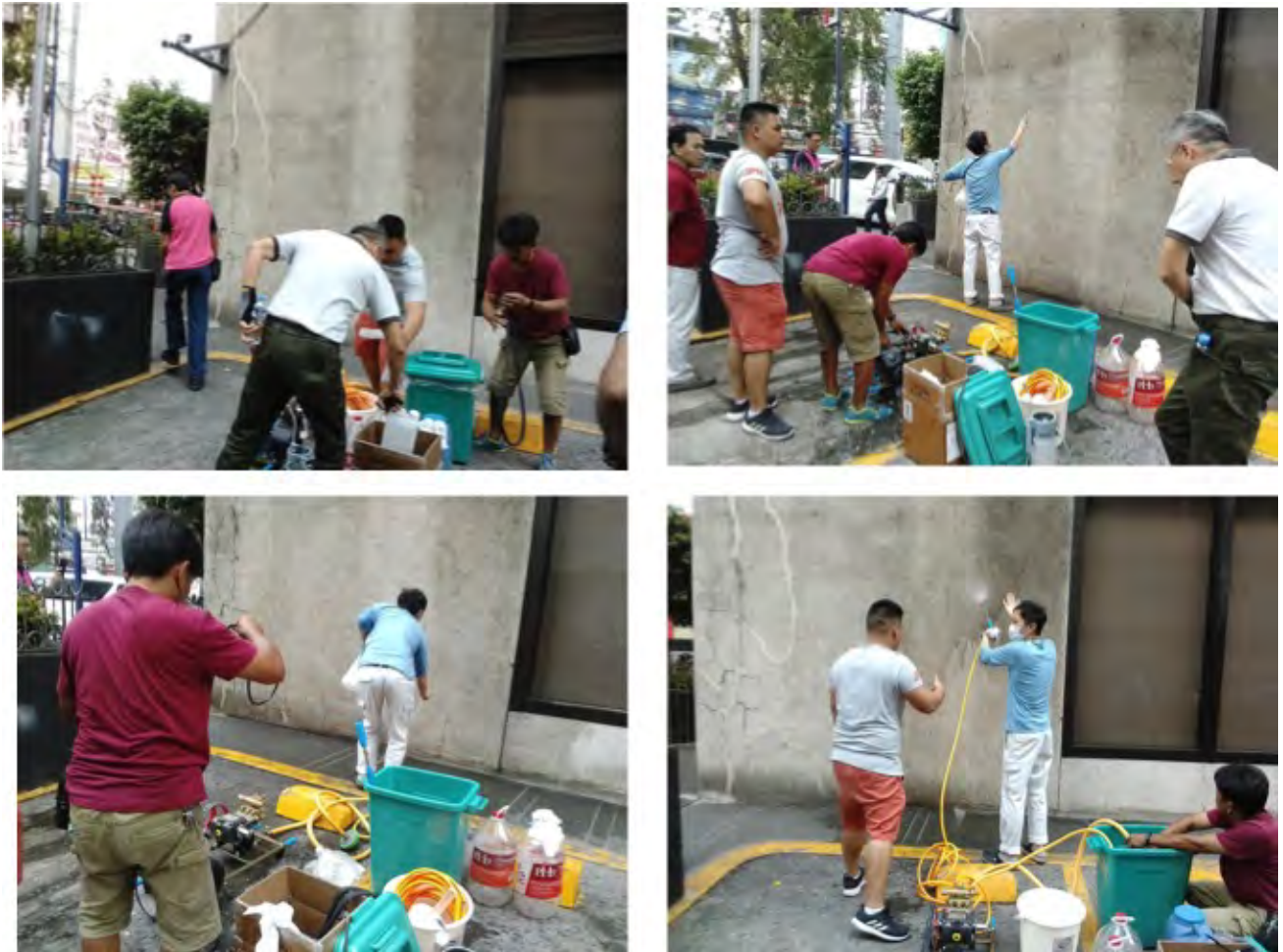
図 16 エバープロロング施工のデモンストレーション 2
