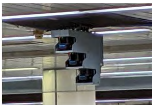
図 8-13 定位置停止検知システム
