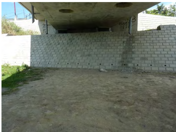
A1 橋台と前面のブロック積擁壁
