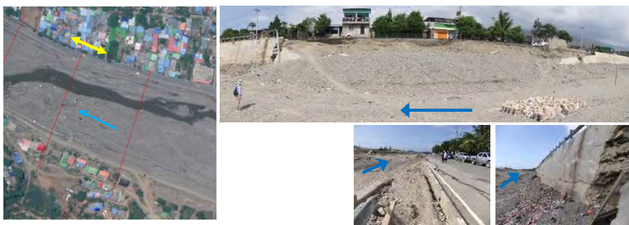
図 25 護岸の被災 (R6)
