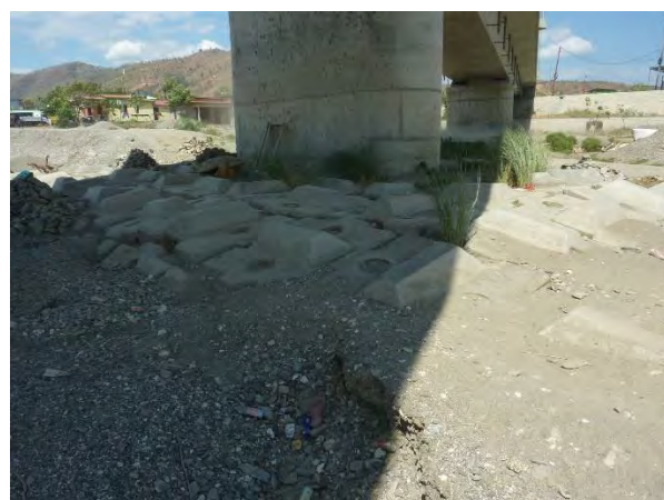
P4 橋脚の根固めブロック
