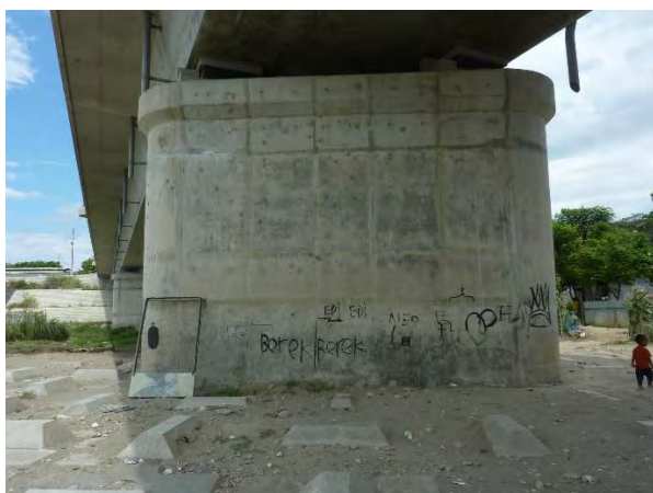
P2 橋脚と根固めブロック(P3 橋脚側)
