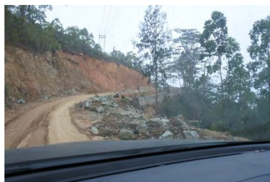
図 37 国道 2 号線の横断カルバートや擁壁工事
