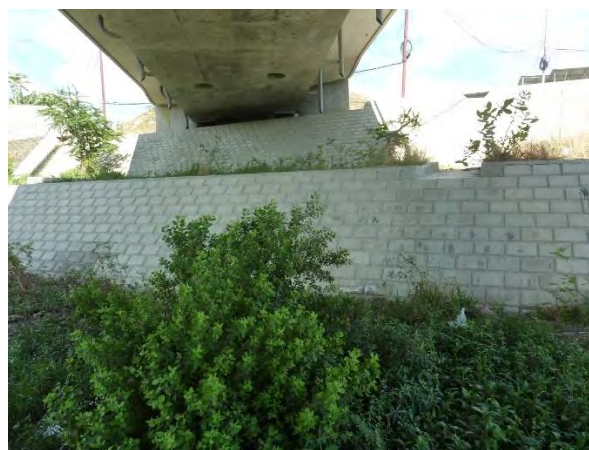
A2 橋台と前面のブロック積擁壁
