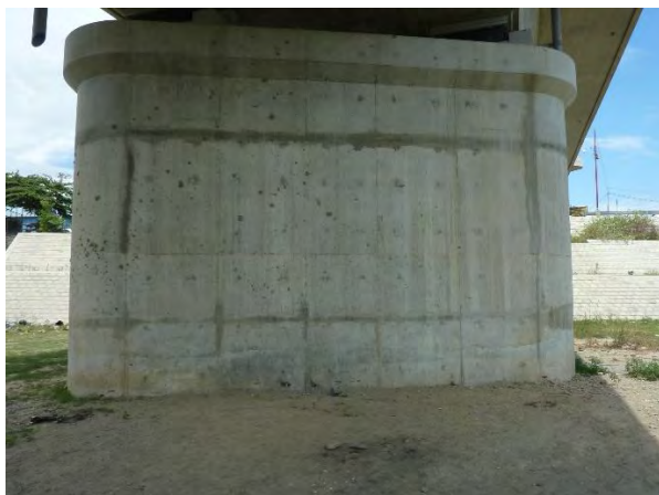
P1 橋脚(A1 橋台側正面)
