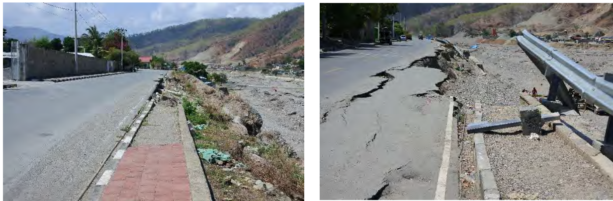
図 30 左 3.8km(R5)地点、右 4.1km(R6)地点の道路破損
