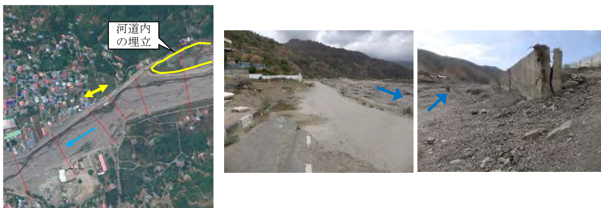
図 26 護岸の被災 (R7)
