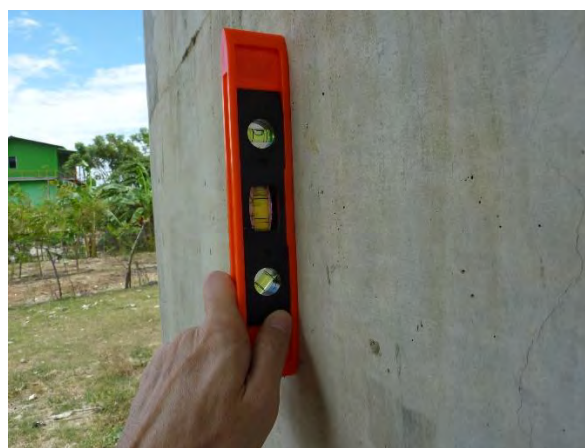
P1 橋脚の鉛直確認
