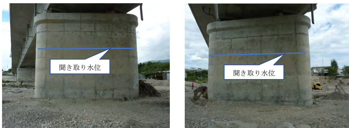
P3 橋脚 (P2 側)
