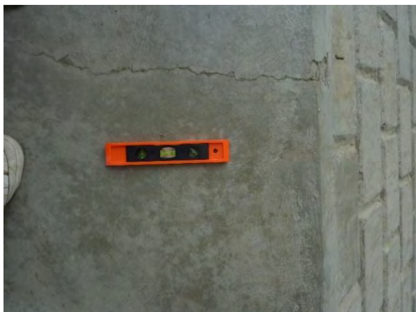
ブロック積擁壁天端の水平測定
