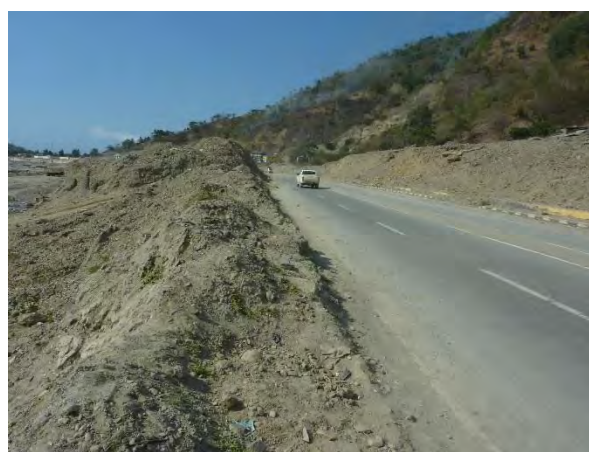
道路両側に積み上げられた土砂
