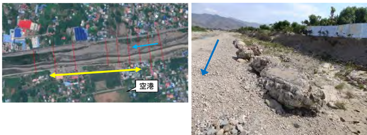
図 19 護岸の被災 (L1)
