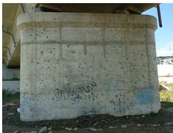
P5 橋脚(P4 側)
