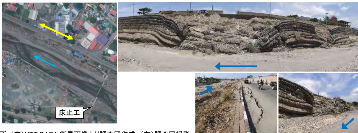
図 24 護岸の被災 (R5)
