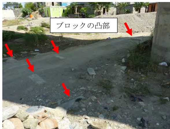
根固めブロック (P4 橋脚部 - P5 側)
