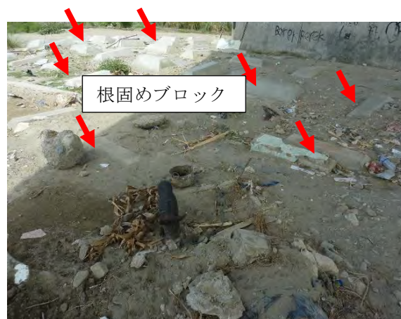
P2 橋脚周り(P3 側)の根固めブロック
