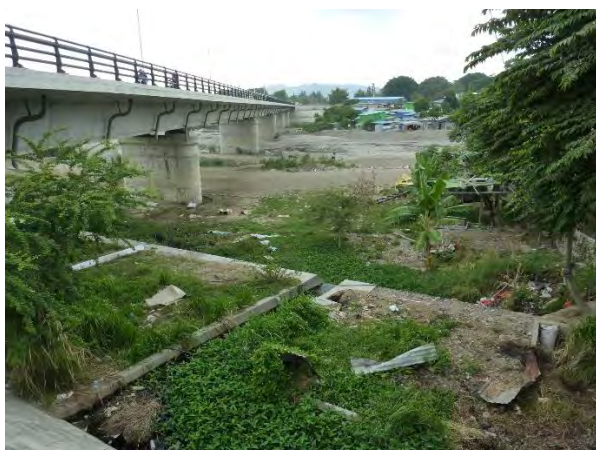
左岸側から河川内橋脚の眺め
