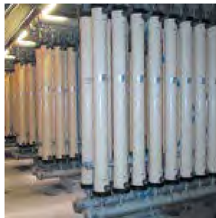
図 4 中空糸型精密膜濾過装置
