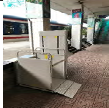
設置後の段差解消機（ハノイ駅） （2019年11月）
