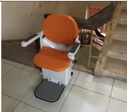
設置後の階段昇降機（ハノイ整形リハビリ病院） （2019年11月）
