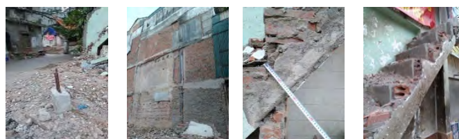
図5 ハノイ市内の建築物解体現場の様子
