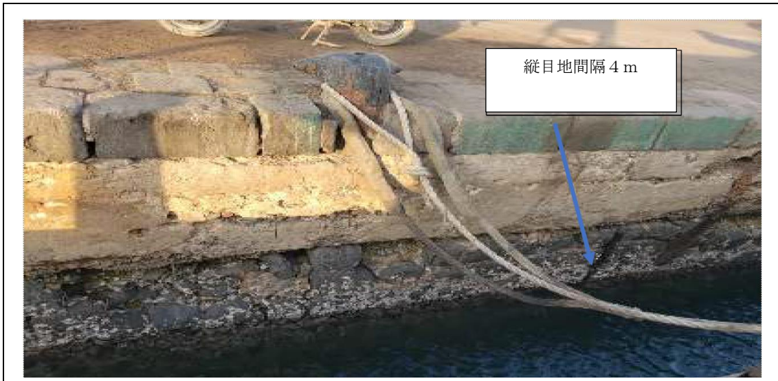
頂部の玄武岩の舗石、その下層にある上部工コンクリート、更に練り石積みの壁体
