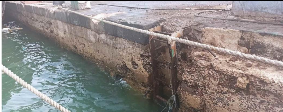
ジブチ港 4 号岸壁側面部
