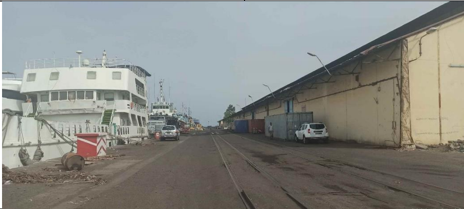
ジブチ港 4 号岸壁
