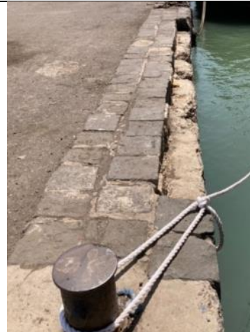
ジブチ港 4 号岸壁ショルダー部 (巡視艇係留予定箇所)
