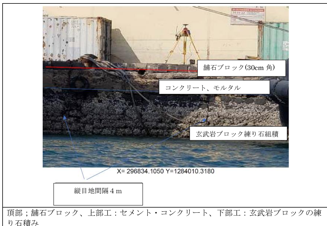
図 2-9：4 号岸壁の現況 1
