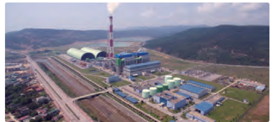
発電所全景（ベトナム「ギソン火力発電所建設事業」）
