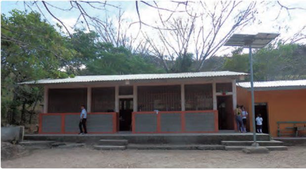
コミュニティ開発計画に基づいて建設された教室(サン・アントニオ・デル・ノルテ市)
