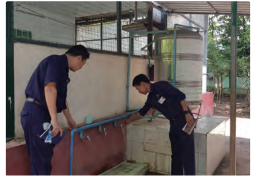
本事業により水圧や水量が改善したヤンキンタウンシップの小学校
