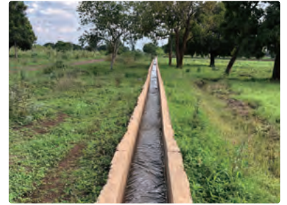
本事業で整備した水路
