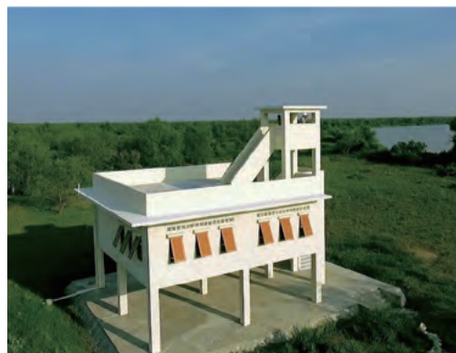
本事業でプロジェクトで供与されたサイクロンシェルター
