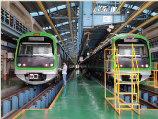
車両保守基地での整備
