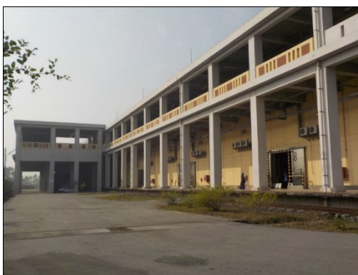
本事業で建設された倉庫
