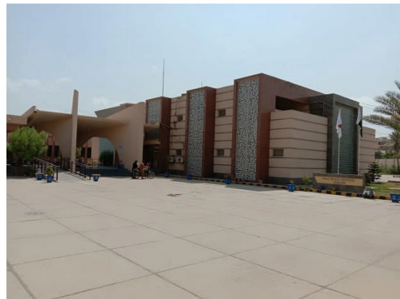
本事業により整備された入院病棟
