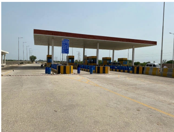
写真 1：本事業で整備された料金所
