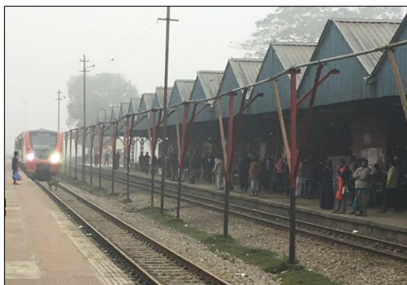
本事業により複線化された線路
