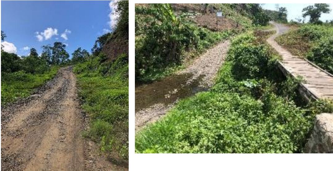
未舗装区間と小橋建設予定地
