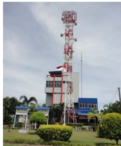
バタム VTS センターの建物外観
