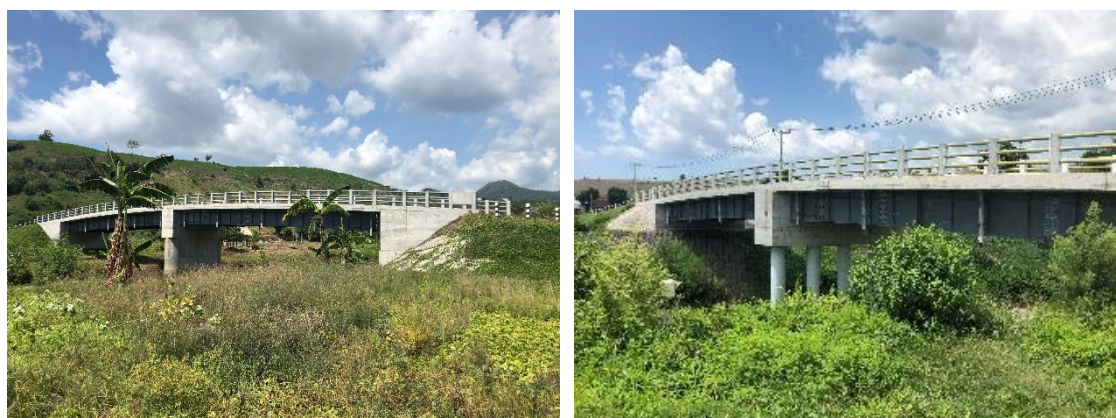
建設された橋梁（左：ラマ 橋、右：エマン橋）
