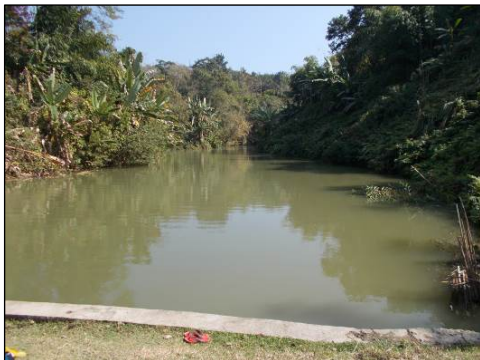
建設されたチェックダム
