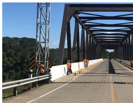
定期保守の様子
