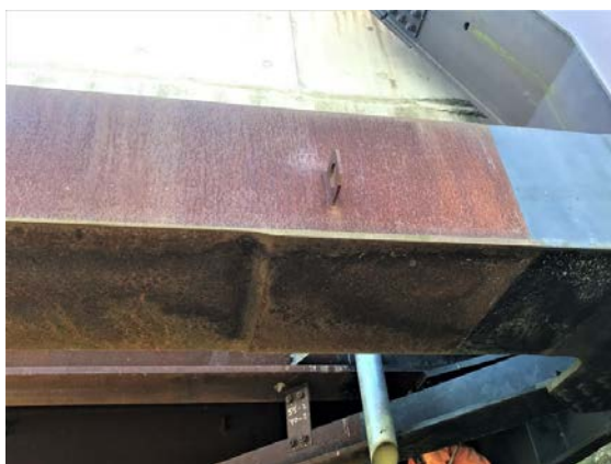
耐候性鋼材（右側は美観のため塗装されている）
