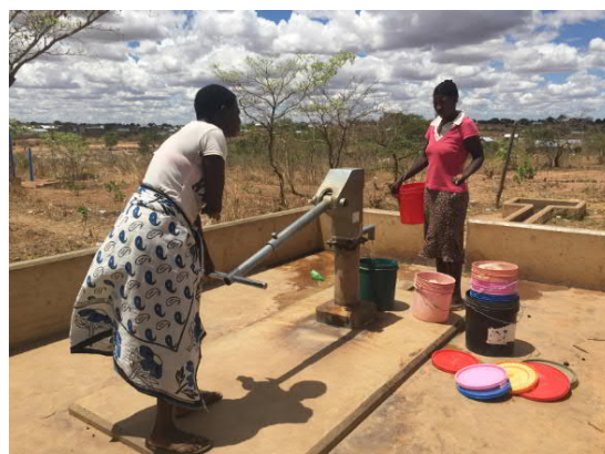
レベル1 給水施設（シコンゲ県）
