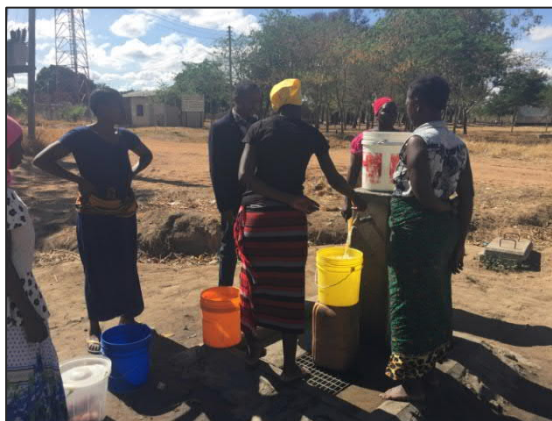
公共水栓式管路給水施設（ウユイ県）
