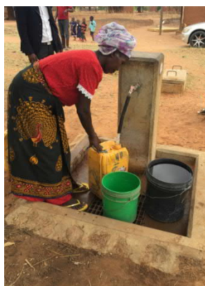
レベル2 給水施設（タボラ市）
