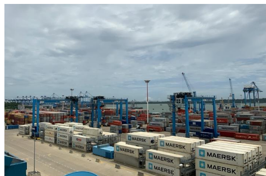
新設された第2コンテナターミナル
