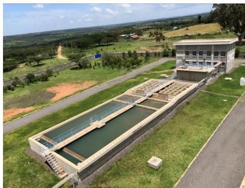
新設された北部浄水場
