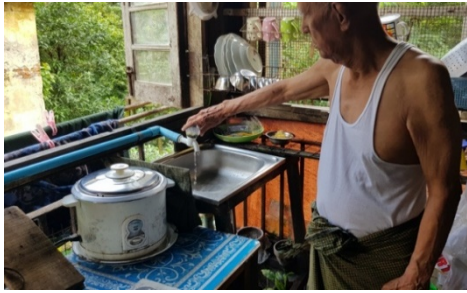
ヤンキンタウンシップの住宅に設置された 給水管
