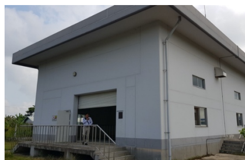
ポンプ棟（事後評価時）
