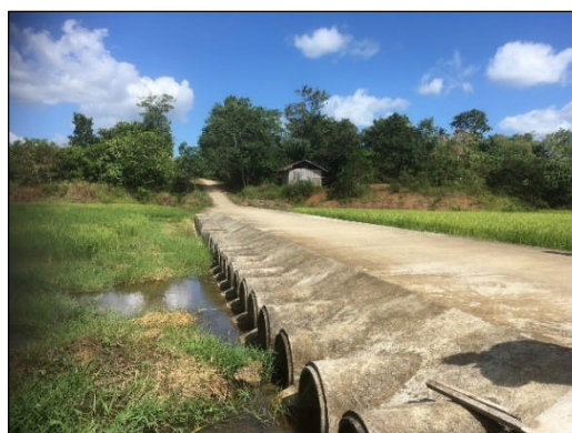
写真 2：本事業で整備された市場アクセス道路 (ボホール州)
