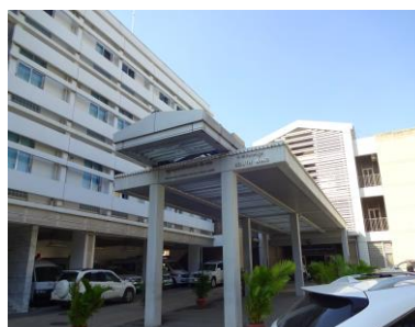
国立母子保健センター (左側が研修棟)
