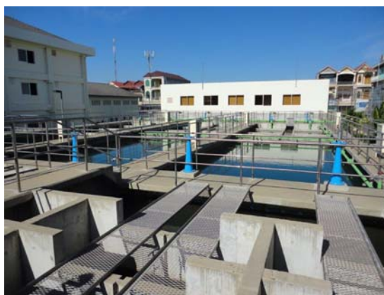
ブロック形成池（手前）と沈殿池（奥） （コンポンチャム）
