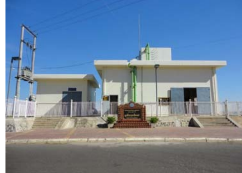
取水操作室・発電機室 (建屋外観) (コンポンチャム)
