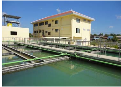
沈殿池と管理棟 (バットバン)
