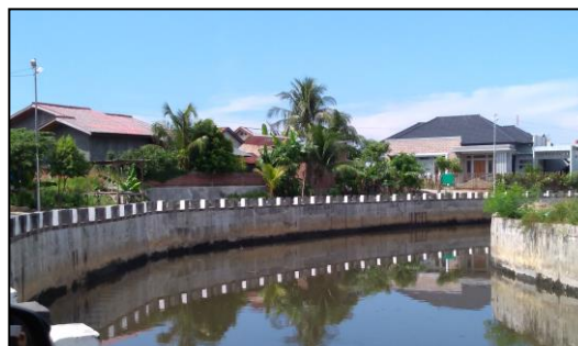
本事業により整備された バンダアチェ市の排水施設
