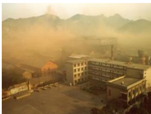
项目实施前的钢厂面貌 (照片：事后评估报告)
