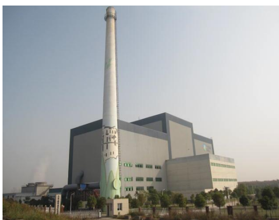
已建成的生活废弃物焚烧设施（安徽省） （照片：事后评估报告）
