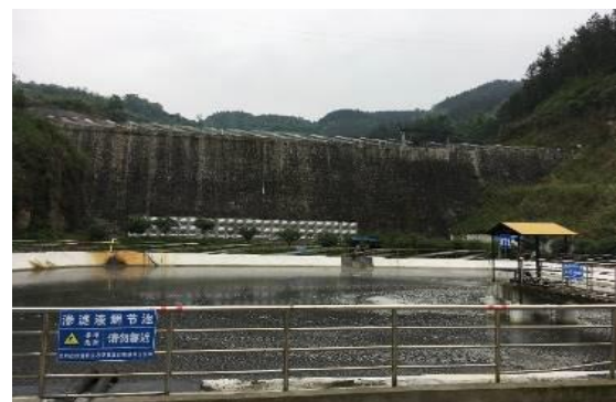
渗滤液处理设施（贵州省） （照片：事后评估报告）
