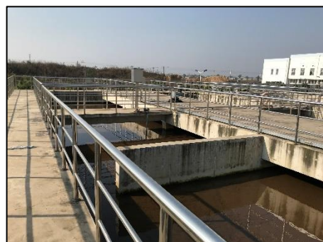
河南省南阳市污水处理厂
