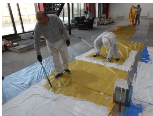
現地でのゲル布への塗布実施（2019年10月）
