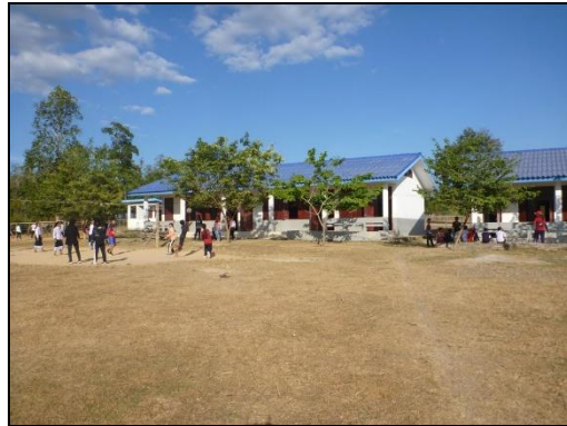
本事業で建設された校舎
