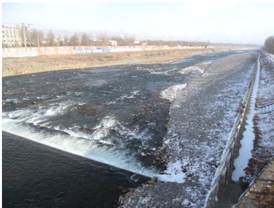
本事業で実施された河川護岸工事
