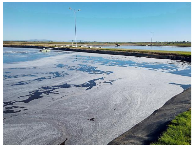
本事業により整備された下水処理場 (ケミセット市)
