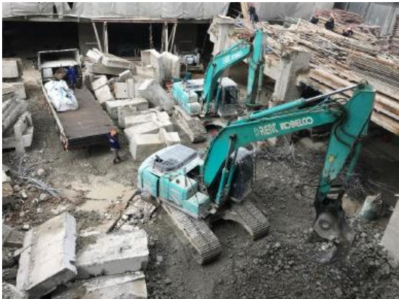
ビル解体現場におけるコンクリート塊切り出し状況
